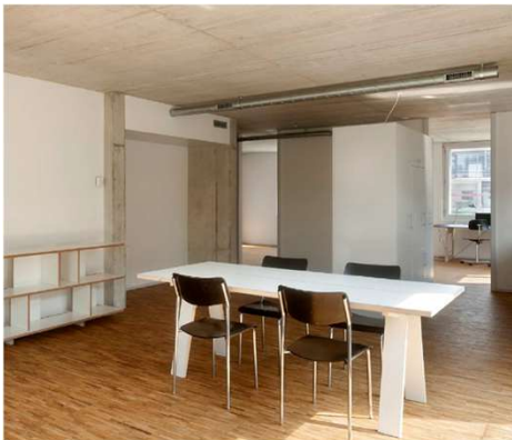
Sichtbare Lüftungsrohre Siedlung Burgunder, Bern Bürgi Schärer Architekten AG, 2010
